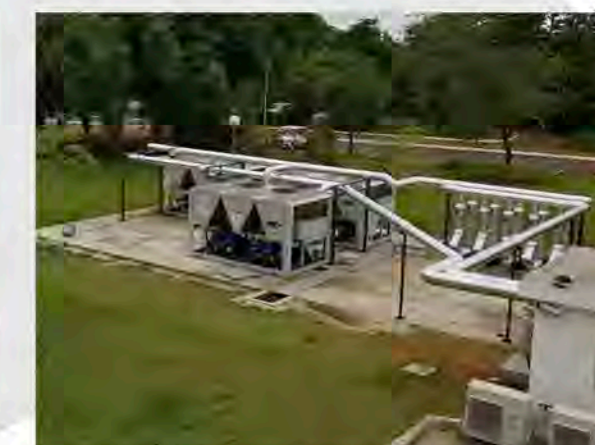
Revitalização do sistema central de ar condicionado do prédio da Direção.
