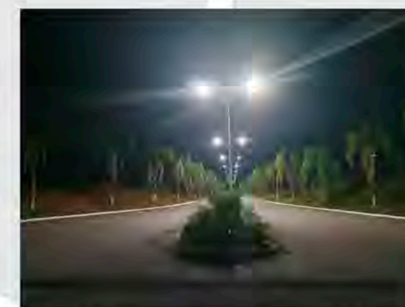
Troca da iluminação das vias internas para LED.
