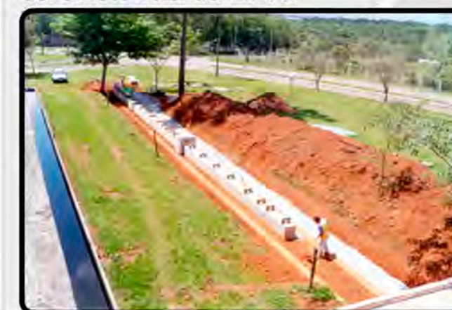
Construção da base inercial para o novo Zarabatana (2002).
