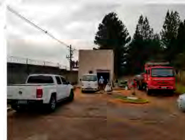
Reforma da cabine de medição de média tensão.
